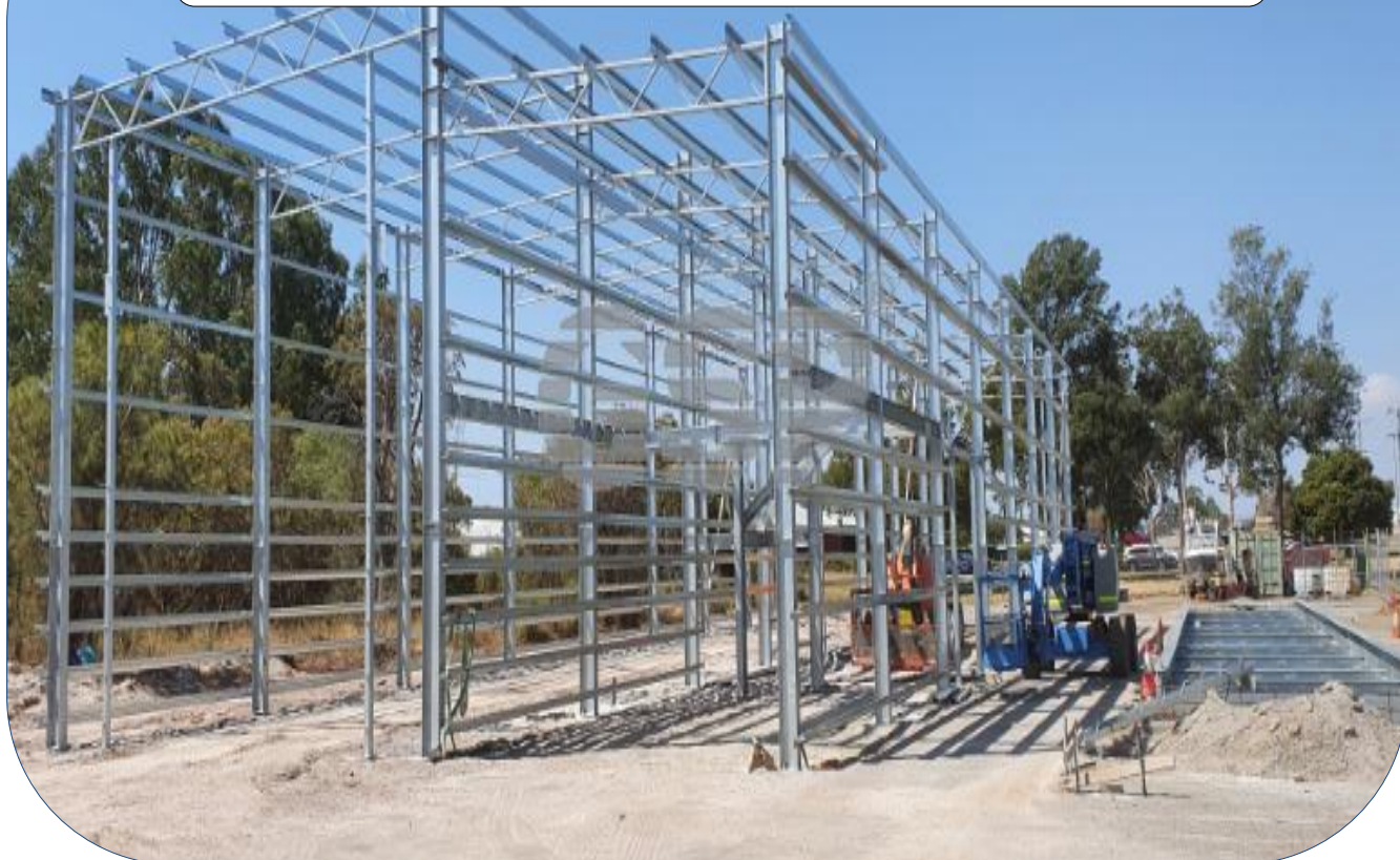
Công trình xuất khẩu: Nhà rửa xe Export work: SHED - TRUCK WASH BUILDING - CANNING VALE
