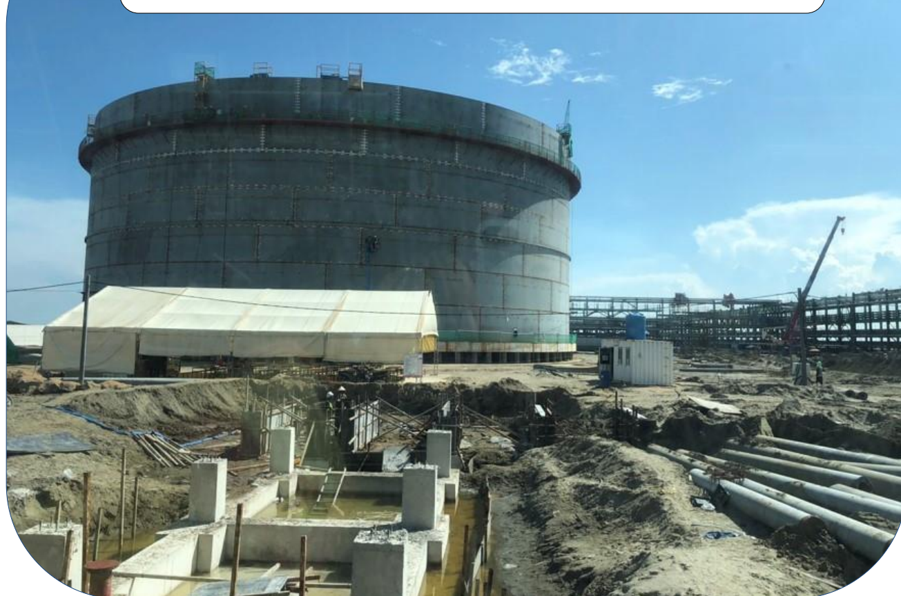
Công trình: Nhà Máy Nhiệt Điện Long Sơn Project: Long Son thermal power station – Baria Vung Tau
