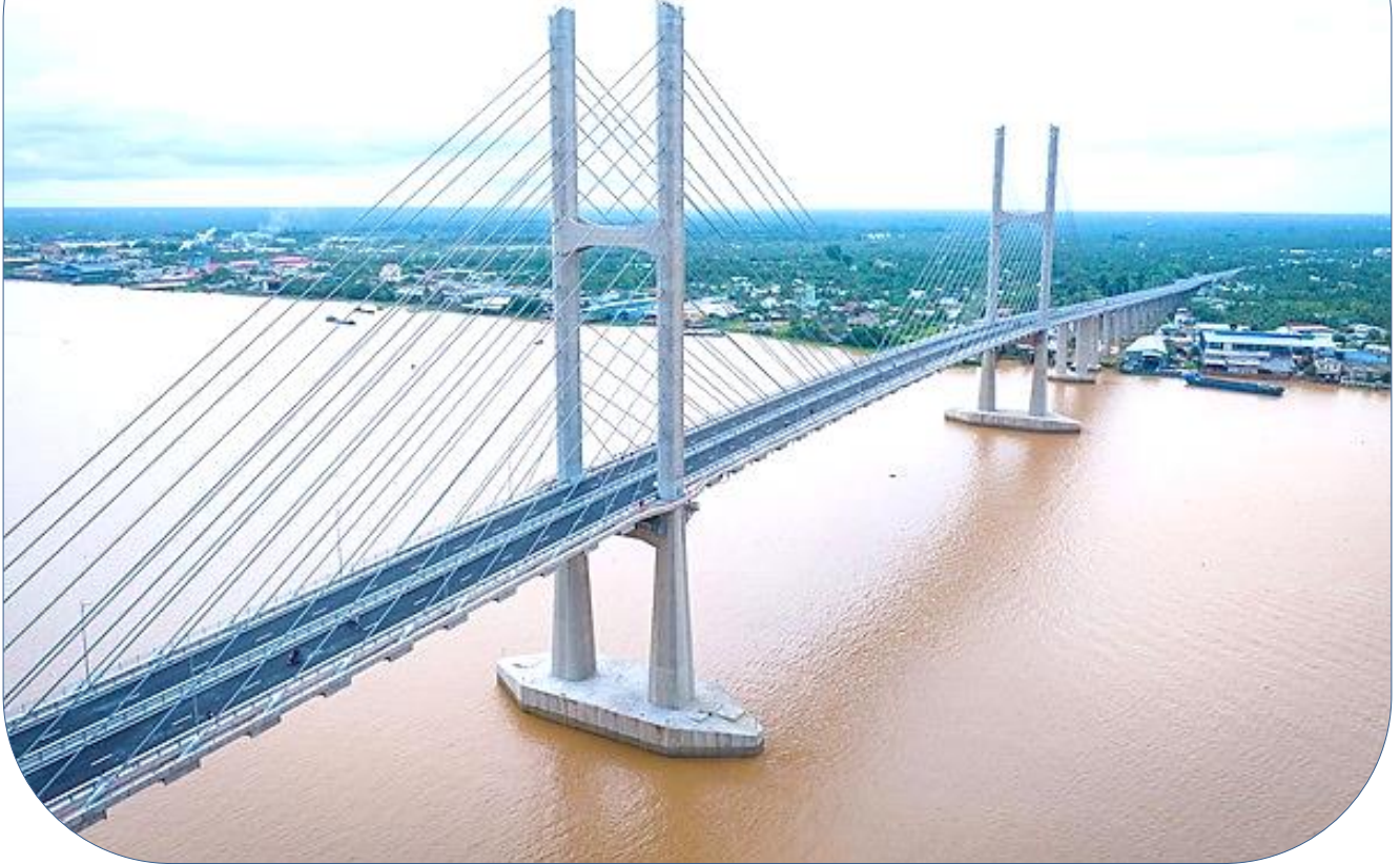
Công trình: Cầu Rạch Miễu 2 Project: Rach Mieu 2 Bridge
