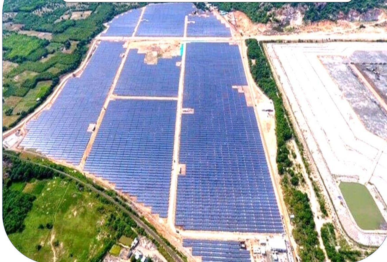
Công trình: Điện năng lượng mặt trời - Bình Thuận Project: Solar powered energy - Binh Thuan
